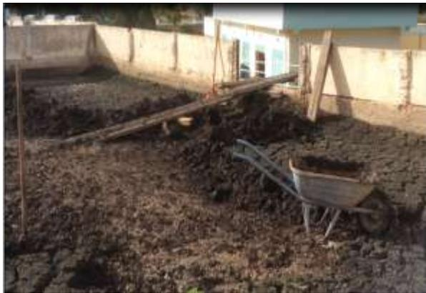
**Figure 24:** la boue ramassée manuellement avec la pelle et transportée à l'aide d'une brouette vers l'aire de stockage
