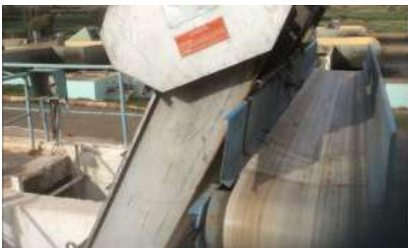
**Figure 19** : Déchets acheminés par un tapis roulant (dégrillage)
