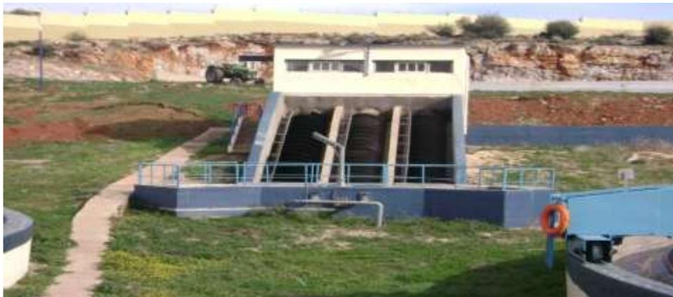
**Figure 15 : Vis de recirculation**
