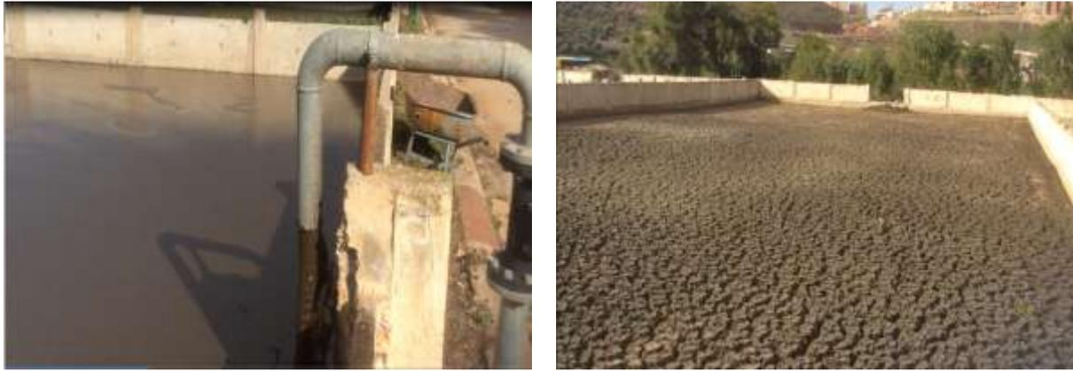
**Figure 23:** la boue étalée au niveau des lits de séchage
