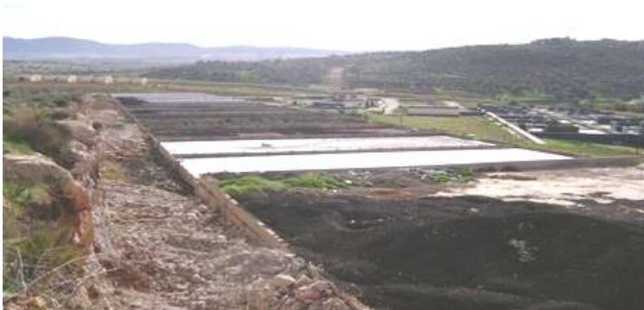
**Figure 17 : Lits de séchage +Aire de stockage**
