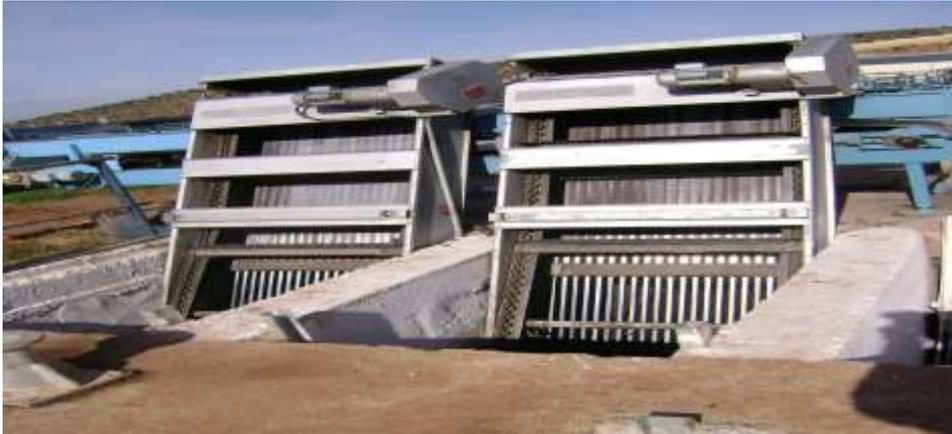
**Figure 10 : Grille mécanisée (2 unités)**
