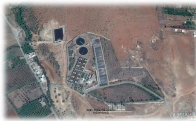
Figure 06: Vue de la station d'épuration d'Ain El Houtz (Google Maps 2019).
