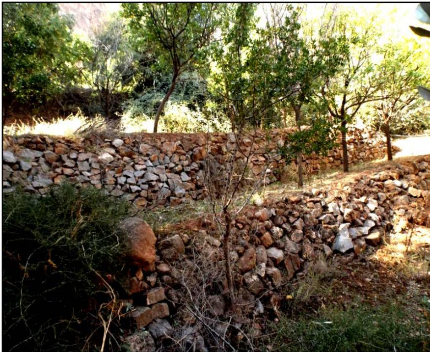
**Photo 21** : terrasses avec murets en pierres totalement construites avec les pierres tirées du terrain aménagé ou emportés d'un autre endroit.
