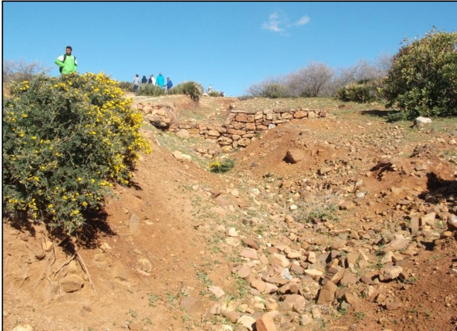
**Photo 4 :** aménagements des ravines avec des gabions en pierres détruits.
