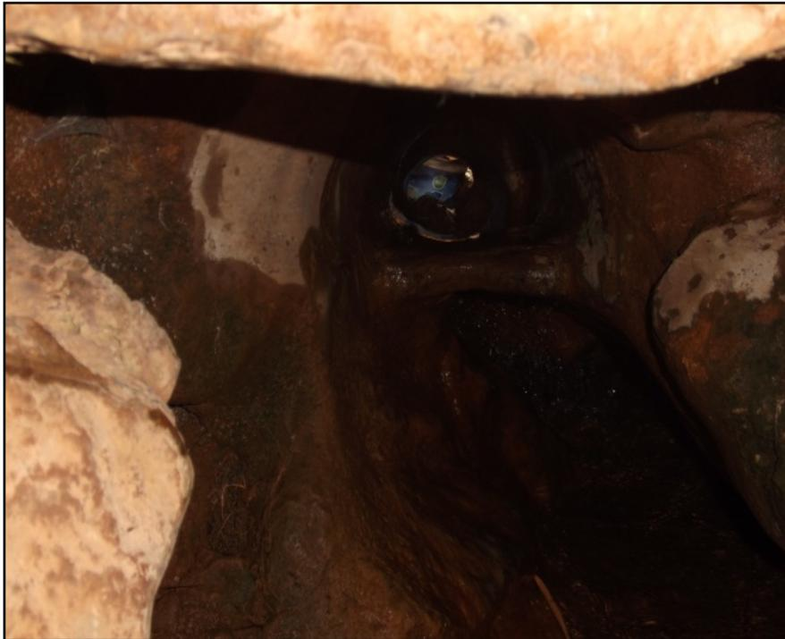
**Photo 12.a** : orifice d'évacuation des eaux stockées pour l'irrigation.
