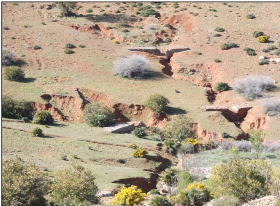
**Photo 3 :** aménagements des ravines avec des gabions en pierres fonctionnels.
