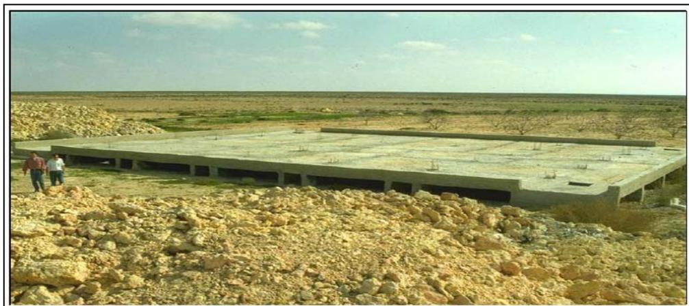
**Photo 9 :** citerne en béton d'un volume de stockage de  $3000 \text{ m}^3$ , construit dans la région de Marsa Matrouh, NW Egypte. Photo: Prinz in Prinz (2002).
