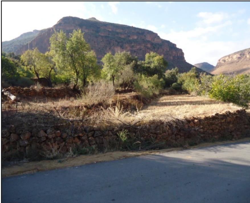
**Photo 19** : terrasses avec murets en pierres creusées et remblayées.
