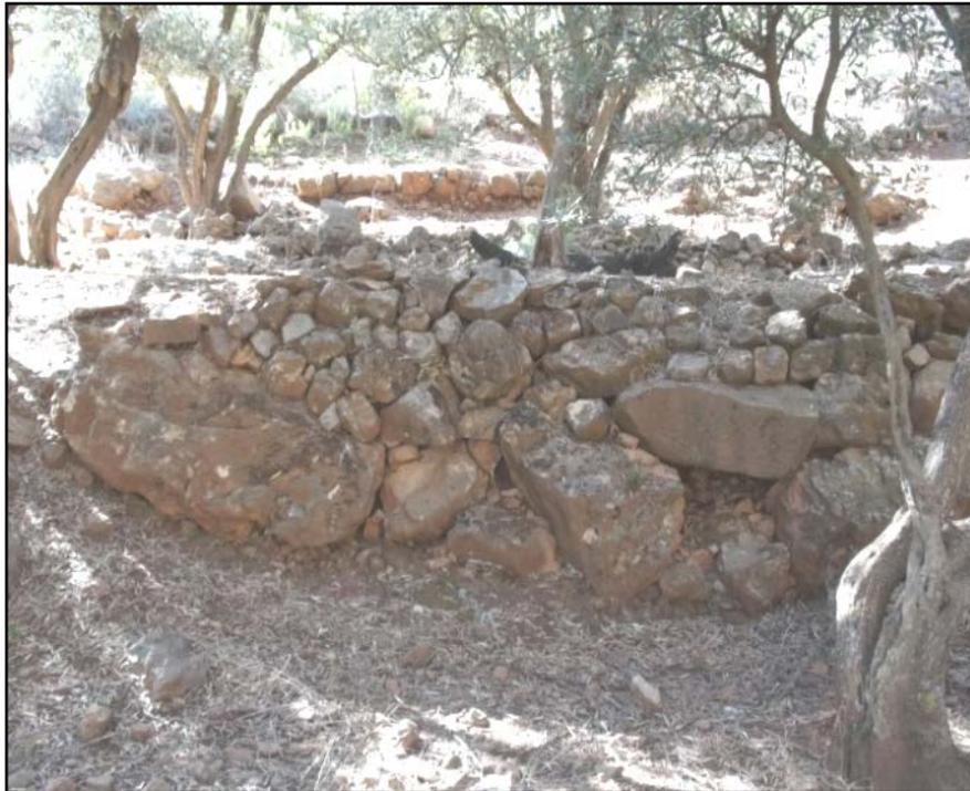
**Photo 22** : terrasses avec murets en pierres en structure composite.
