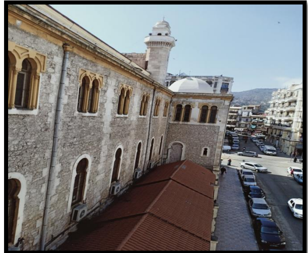
- صورة رقم 53: الواجهة الشمالية للمسجد.
