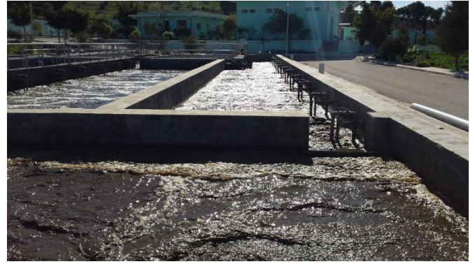
I8 : Bassins de digestions.
