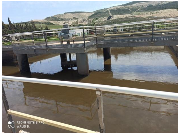
III5 : Bassin d'aération
