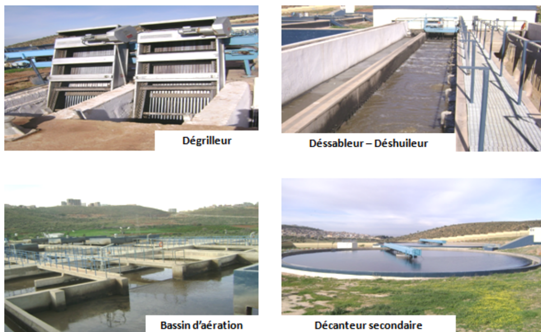
FIGURE 1 – Quelques unités de traitement dans la STEP de Aïn El-Houtz à Tlemcen
