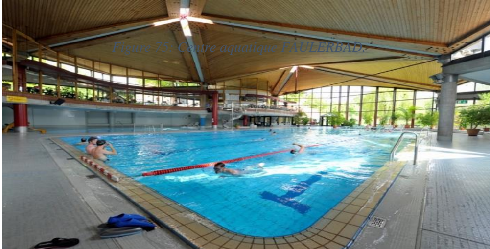
Figure 76: couverture piscine du Centre aquatique FAULERBAD en BLC.
