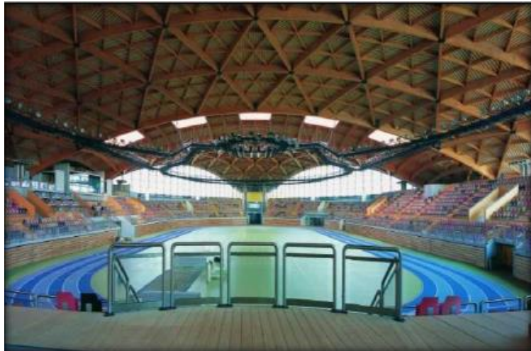
Figure 163: La structure du Centre national sportif et culturel, Luxembourg.
