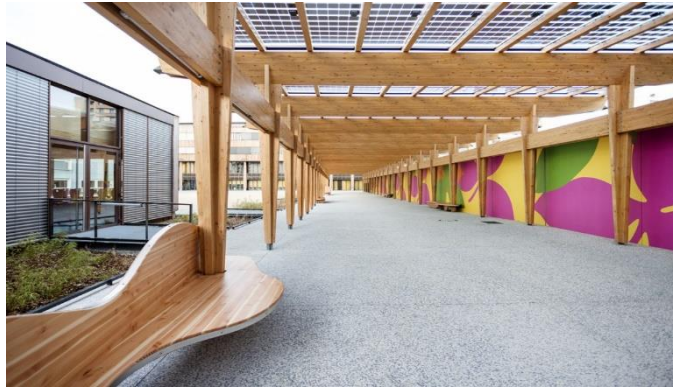
Figure 38: Photo d'exemple du Lycée les eaux claires, Grenoble, France. Système poteaux poutres en BLC.
