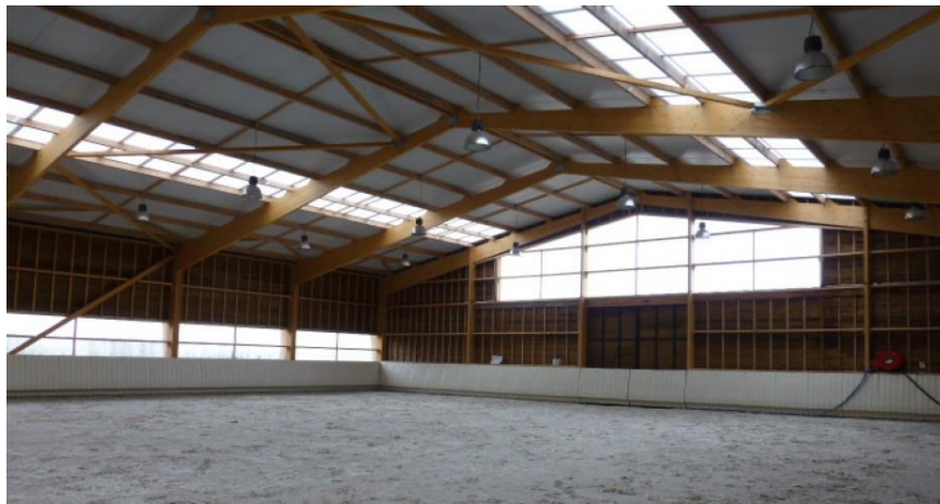
Figure 55: Ecuries du Clos Ferré à Villégat.
