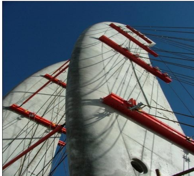
Figure 147: Photos montrant les colonnes incurvées avec systèmes de câbles, Arena, Zagreb, Croatie.
