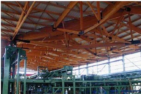
Figure 11: usine de bois lamellé collé (Saint-Avit)
