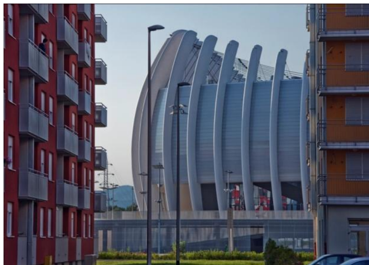
Figure 145: Photos montrant les colonnes incurvées de la façade en Béton, Arena, Zagreb, Croatie.
