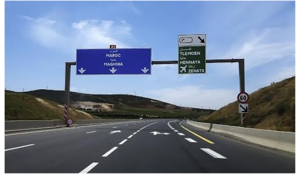
Figure 103: Autoroute et réseaux routiers nationales
