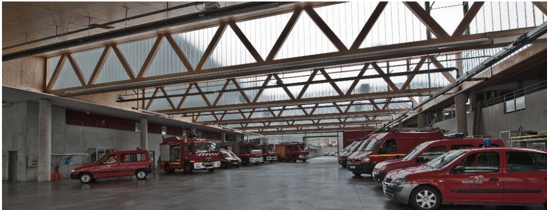
Figure 52 Centre de secours de Gouzé.
