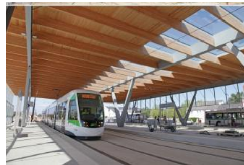
Figure 12: Auvent du pôle Haluchère du tramway nantais (Nantes)
