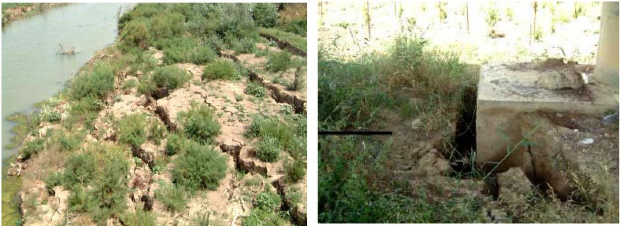
**Figure I.5** : Liquéfaction des sables au niveau du pont Isser-BOUMERDES en 2003 (à droite) le déplacement latéral du sol autour de la se melle de la pile et la remontée de l'eau (à gauche).
