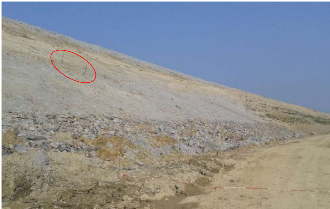
Fig 3. 4 : Repères de nivellement installés sur les talus d'un remblai
