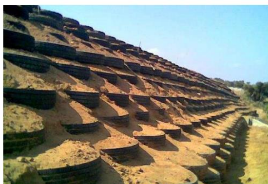
Figure 3-12: chantier expérimental Pneusol à bou-smail
