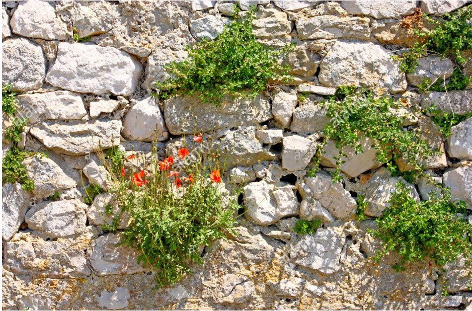
Figure 4: Murs sans joints repère idéal pour la flore des murs
