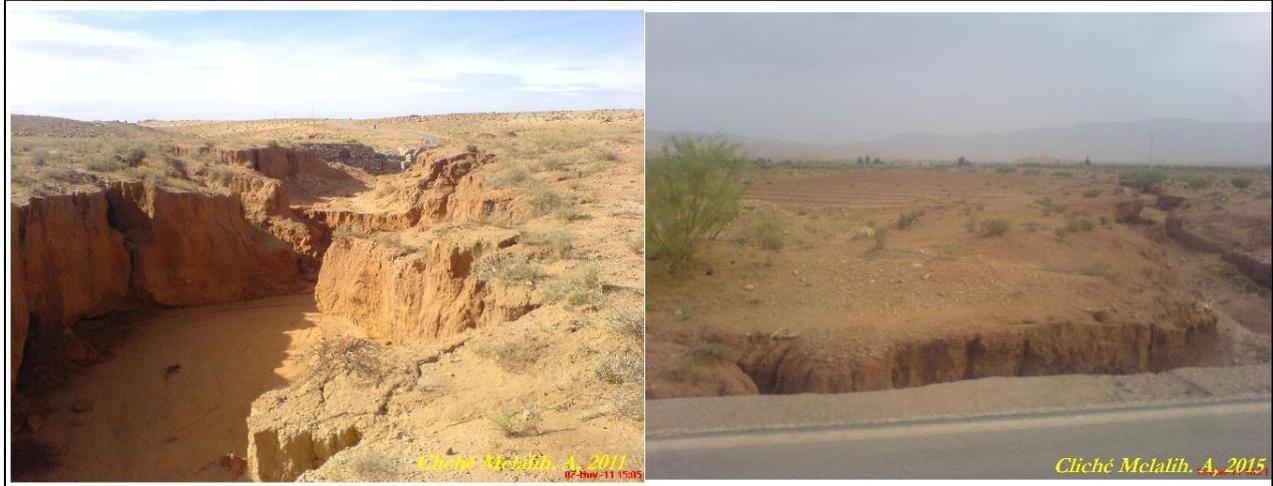
**Figure 7.** Erosion par ravinement sur le site de Sffisifa, malgré l'existence d'un seuil en gabion en amont.
