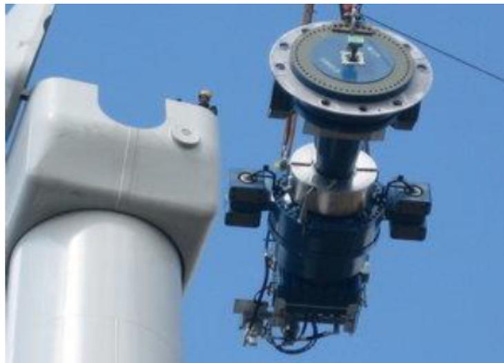
FIGURE I.7 – Assemblage d'une nacelle sur une éolienne à axe horizontal [14]
