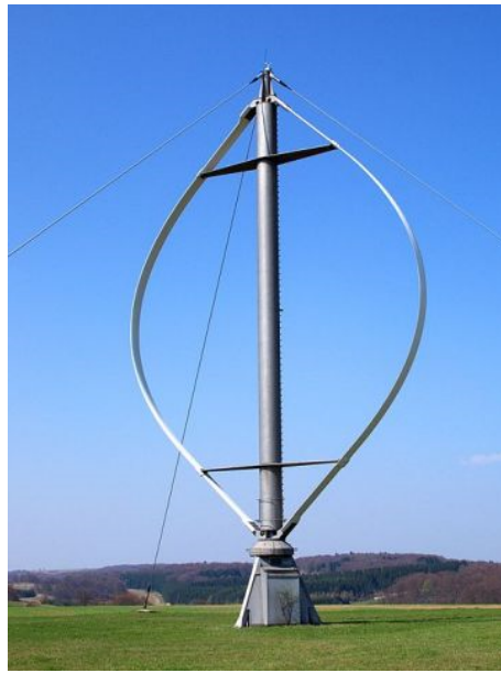
FIGURE I.7 – Aérogénérateur à axe vertical (structure de Darrieus)
