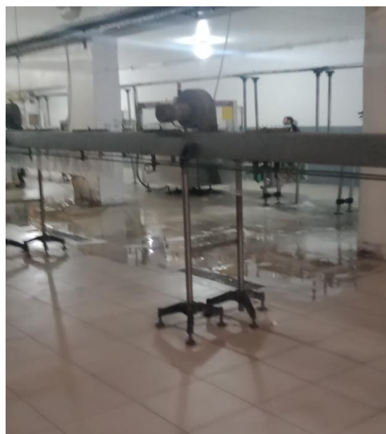
Figure 31: trop d'eau sur le sol de travail
