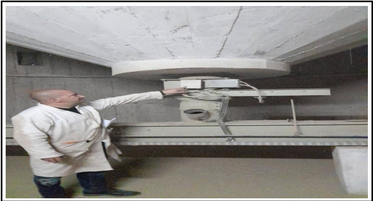
FIGURE I. 20: un silo de stockage
