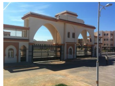
Au niveau du Wilaya Etablissement public hospitalier de Remchi
