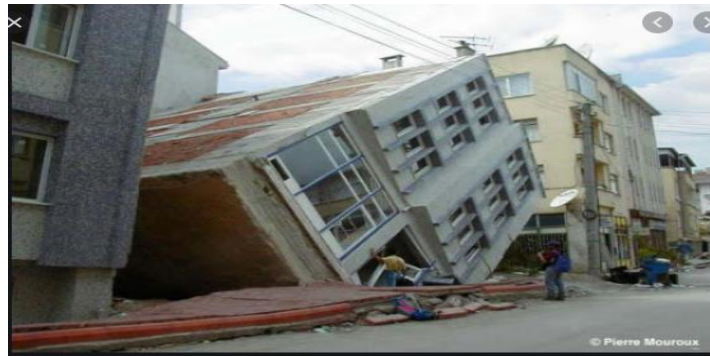
Figure 1-1 : Liquéfaction du sol et ses conséquences
