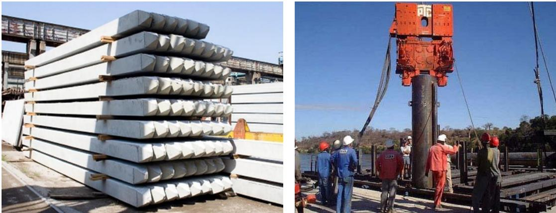
Figure 1.3 : Pieu battu préfabriqué
