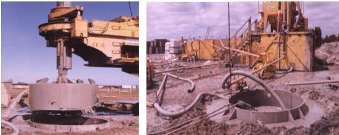
**Figure 1.6: Pieux forés avec boue**
