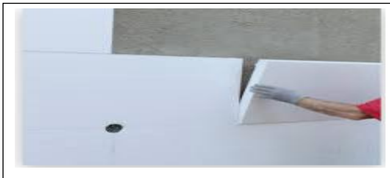
Figure 7.7 : Murs en polystyrène
