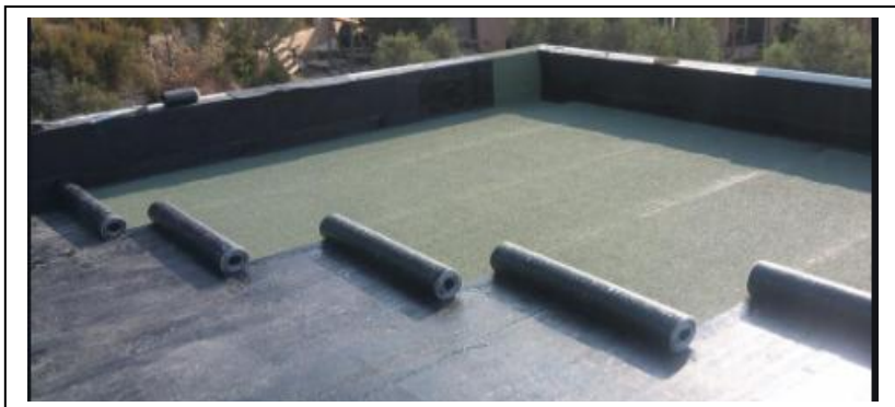
Figure 7.5 :Etanchéité du toit terrasse
