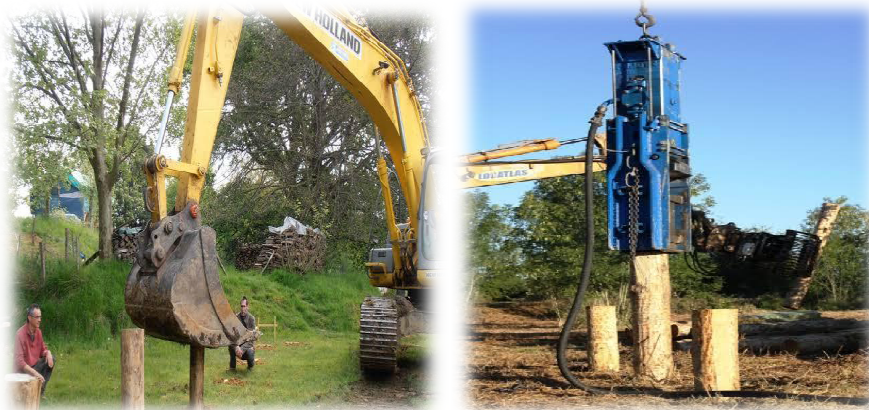
Figure I.4 : Pieux en bois
