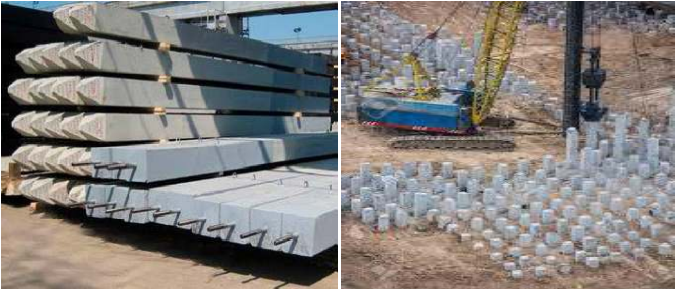
Figure I.6 : Pieux en béton armé
