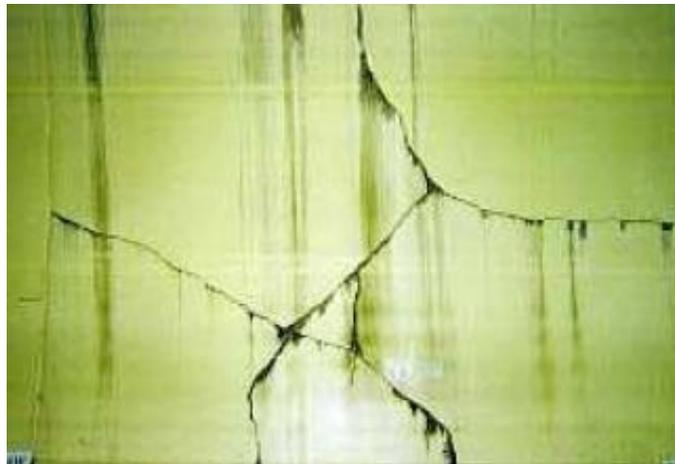
**Figure 1.9** Tunnel de A38 Saltash (R.U, 1997), fissurations sur les parois(Sauer, 2004)
