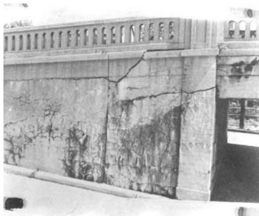
Figure 2.14 : Un exemple d'ouvrage affecté par la réaction alcali-carbonate [79].
