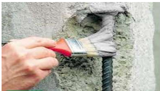
Figure I.8: Traitement des armatures contre la corrosion
