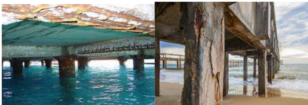
Figure I.1 : Etat d'ouvrages dégradés par la corrosion des armatures
