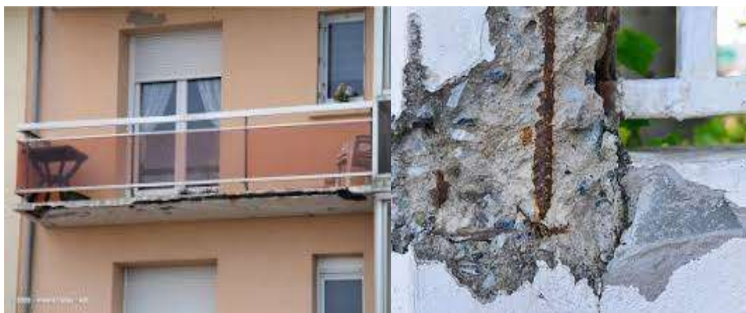
Figure I.4 : Epaufrures de béton d'enrobage: armature apparentes
