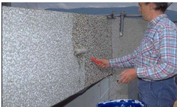
Figure I.14: Application de l'inhibiteur migrateur [26]
