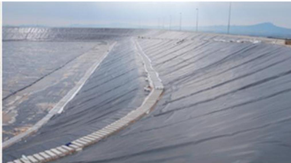
**Figure 28 : Installation Géo membrane**
