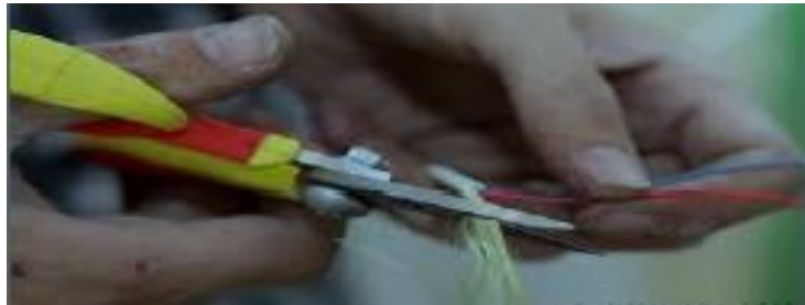
Figure 37: (3.16): Dénuder la fibre optique.
