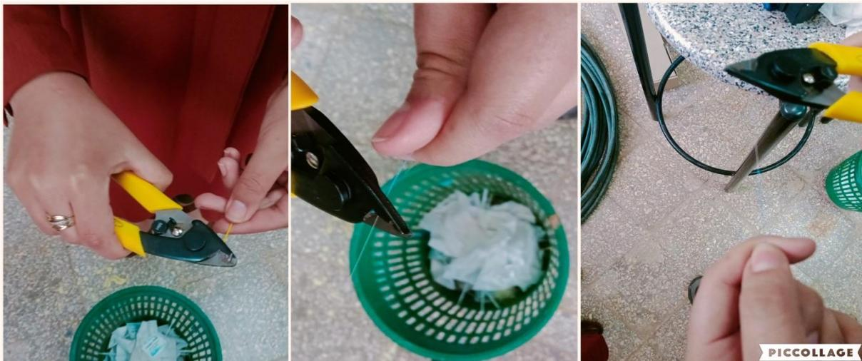
**Figure III.63:** les étapes de dénudage d'une fibre.
