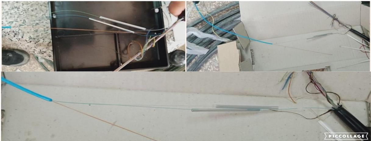
**Figure III.62:** la connexion de deux câbles a fibre optique.
