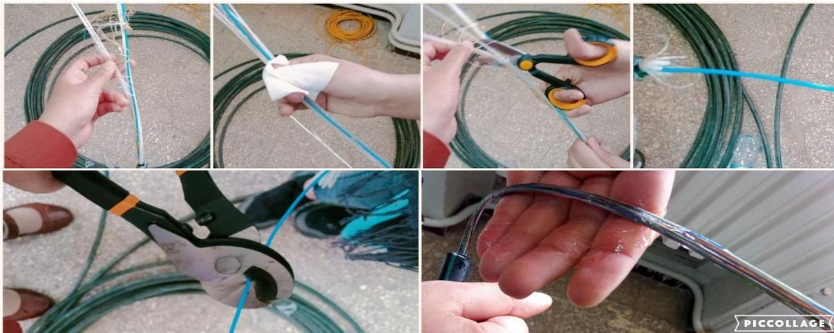
**Figure III.54:** dégainer la gaine intérieure du câble.
