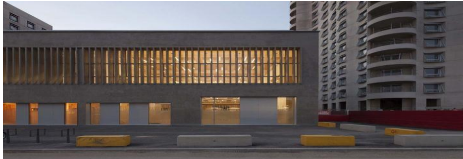
Fig.I.19 : Façade de salle de sport Halle de fleurs
