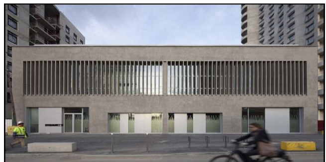
Fig.I.14 : Façade principale de la salle de sport halle de fleurs
