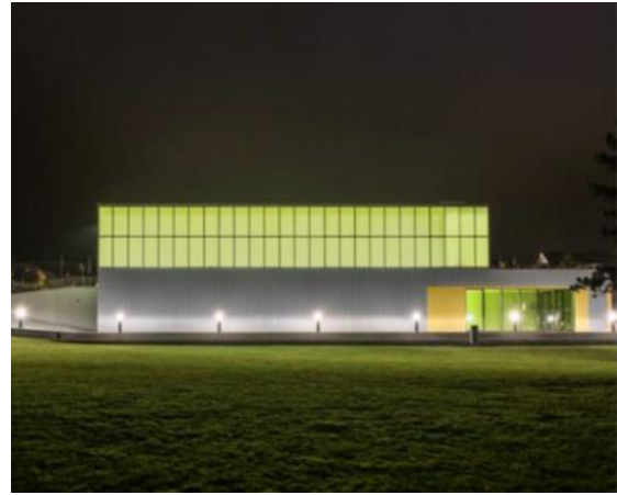
Fig.I.30 : Façade latérale du centre neumatt
