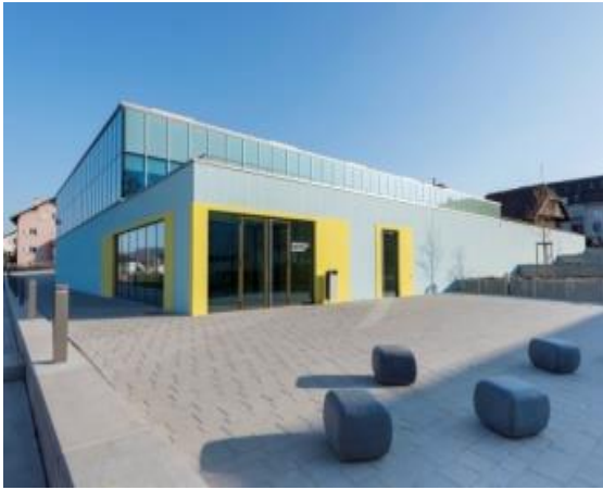
Fig.I.29 : Façade principale du centre neumatt
