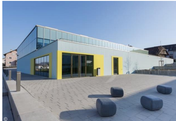
Fig.I.24 : Façade principale du centre neumatt
