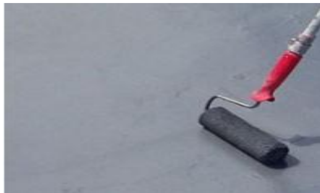
Figure 5: Traitement hydrofuge. (maison-etanche)
