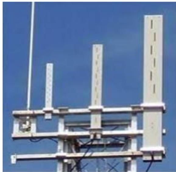
**Figure I.8** Exemple d'une antenne à fentes [8].
