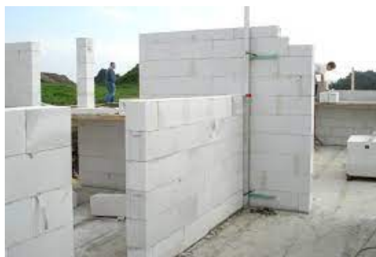
Figure 4. 9 : Construction mur en béton cellulaire
