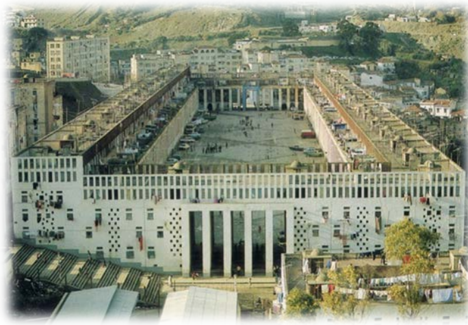
Figure 1. 8: Climat de France à Alger Fernand Pouillon
