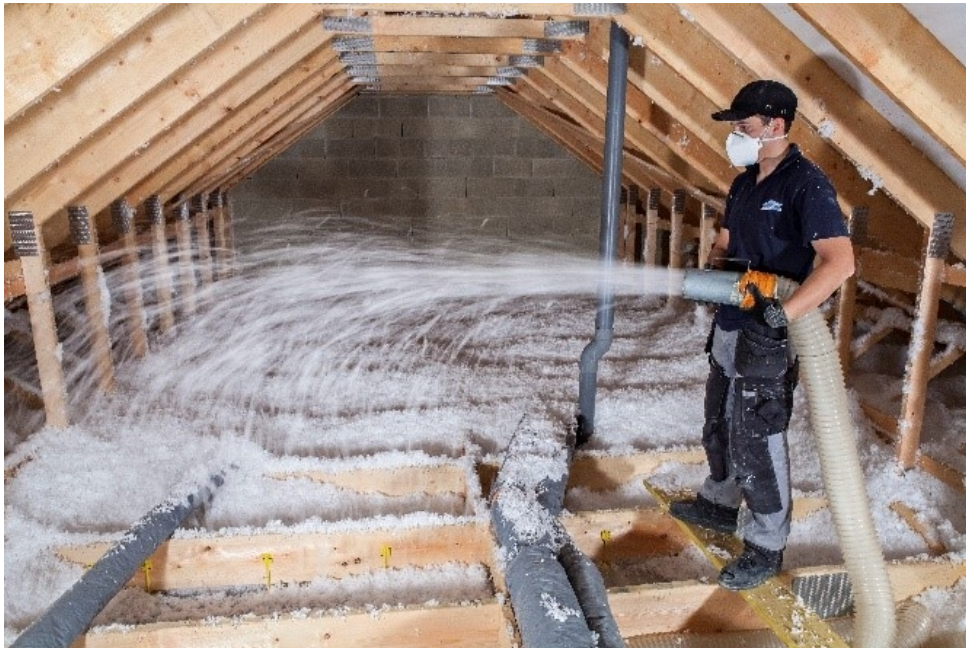
Figure 4. 23 :L'isolation des combles par une laine de verre à souffler
