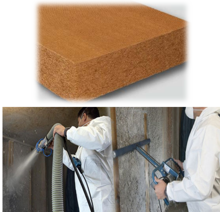
Figure 2. 13: Panneaux de cellulose (doc. Homatherm) et flocons de cellulose humidifiés et projetés.
