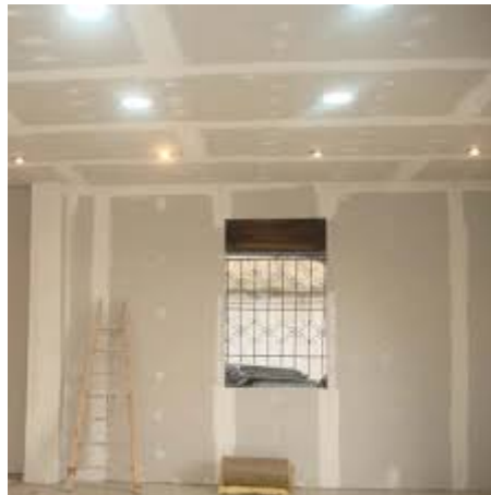
Figure 4. 14 : Pose de plaque BA13 sur murs intérieurs
