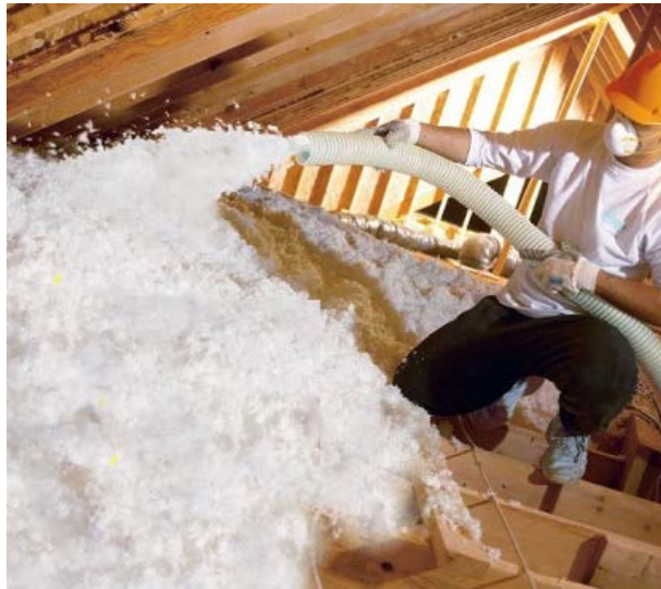
Figure 4. 20 : Projection pneumatique d'isolant
