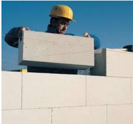
Figure 4. 10 : Pose de bloc en béton cellulaire
