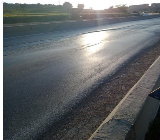
FIGURE I.4 Un affaissement
