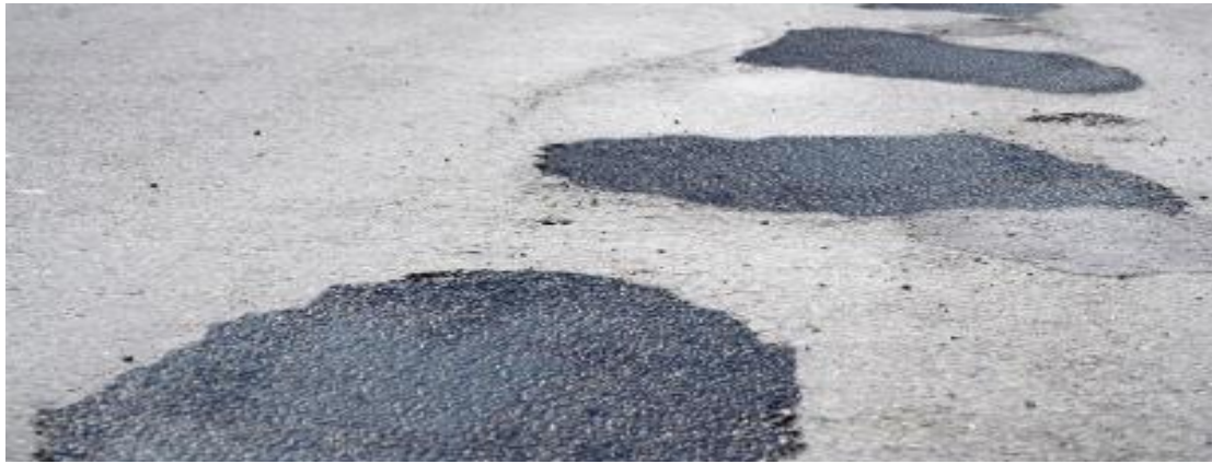
Figure III.3) produit d'entretien et réparation des routes –TOROS- (ore-peinture.fr). [11]
