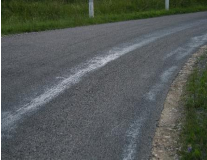
Figure II.3 – Ressuage (mouvements de matériaux) - encyclautomobile.fr -
