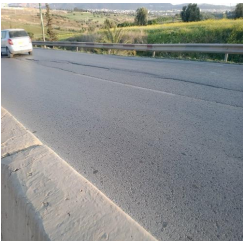
FIGURE I.3 Fissuration longitudinale
