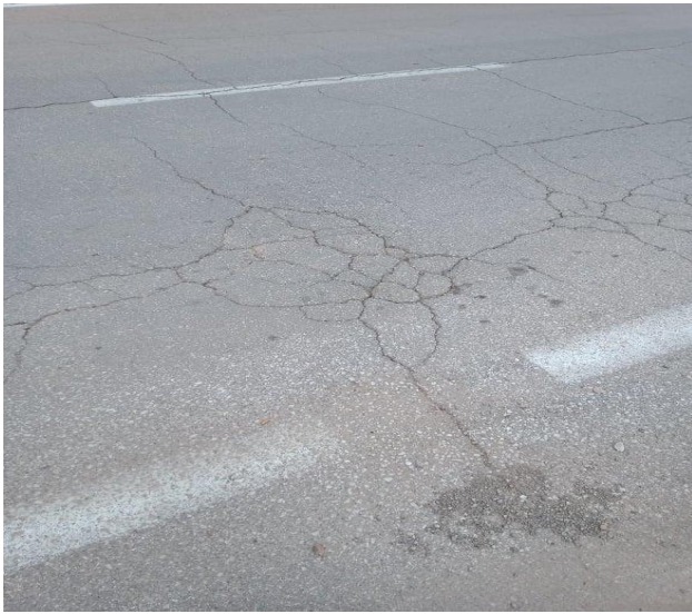
Figure II.17 faïençage a maille moyenne (degré02)
