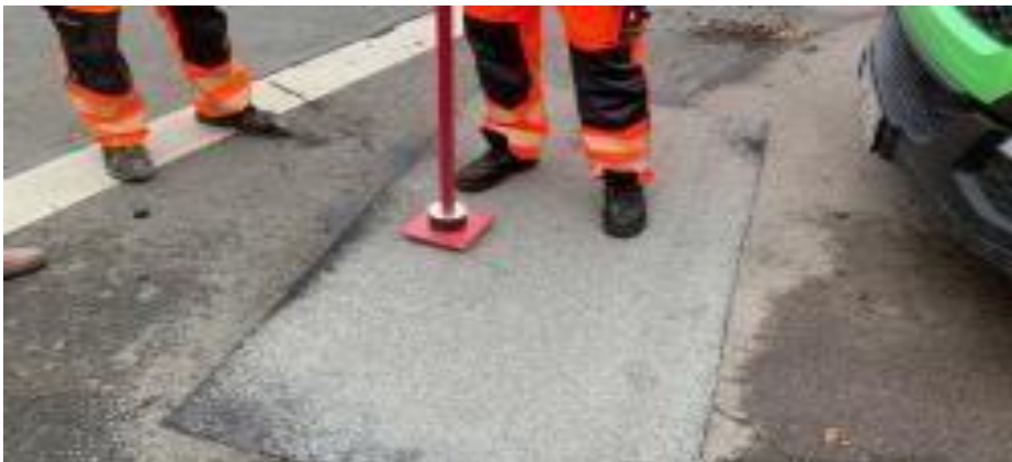
Figure III.1) procédé adhésif pour réparer les routes à moindre coût (Site : www.americanroadpatch.com ). [9]
