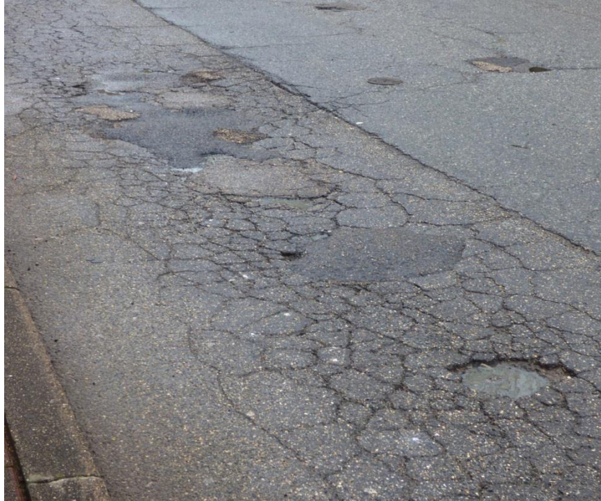
Figure II.9 –l’arrachement et le nid de poule- (ibef.net). [8]
