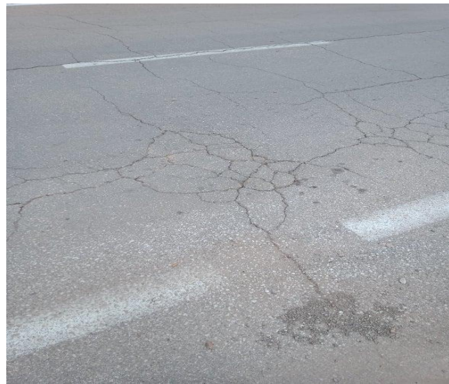
figure II.12 dégradation de surface-faïençage-
