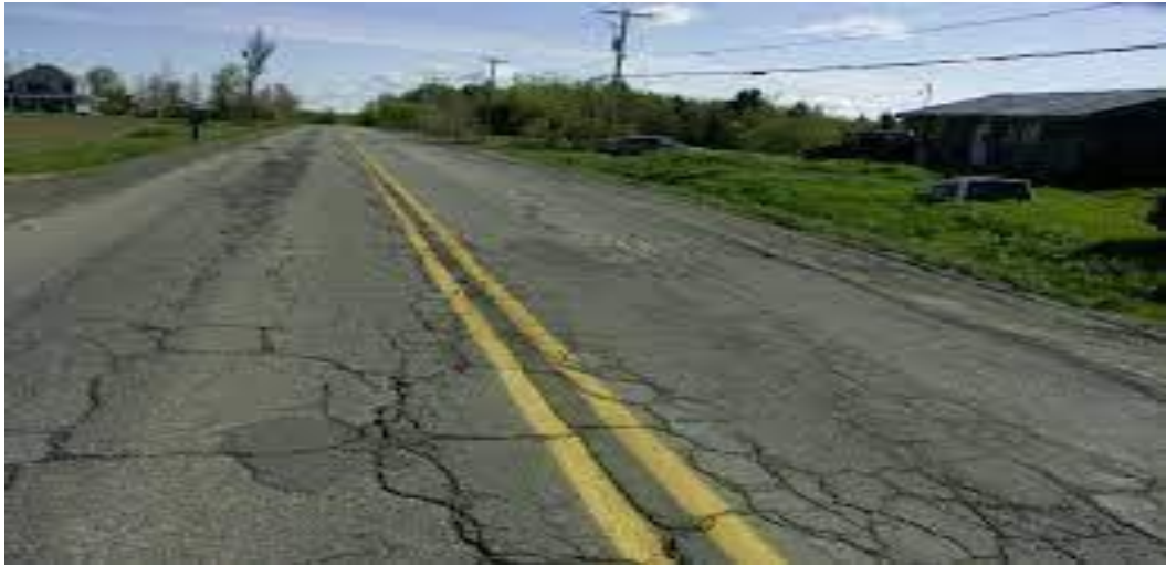
Figure II.10-1'arrachement et remontée des matériaux- entretien de routes -
