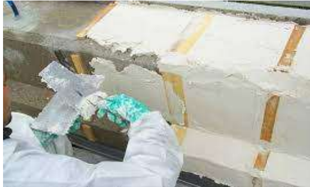
Figure 1.13: Procédé de ré alcalinisation [BOUTEILLER, 2005]
