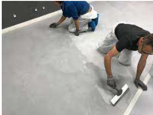
Figure 1.9: Application de lasure sur toiture en béton [AURENTI, M., 2016]
