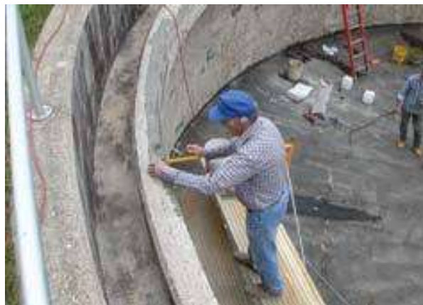
Figure 1.14: Application des inhibiteurs migrateurs [Bear Parkway et al, 2020]
