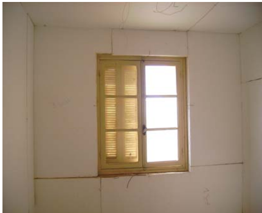
Fig. (2.19) : face intérieure du mur sud.
