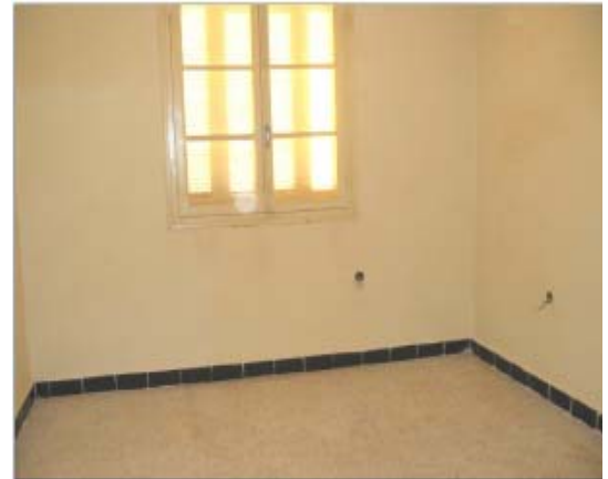
Fig. (2.15) : Photo de la face sud de la pièce sans isolation.
