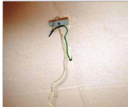
Fig. (2.20) : Photo du toit de la pièce. Position du thermocouple.
