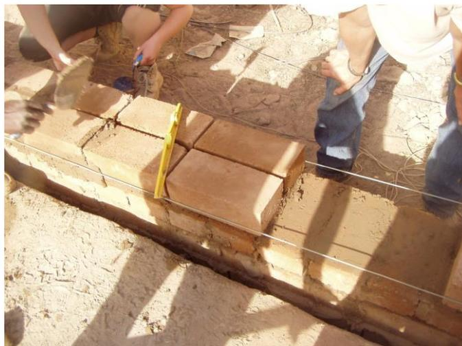
**Figure 1-13** : construction en BTC.
