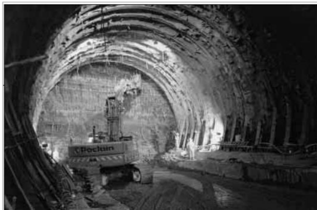
Figure 1.4 Creusement en pleine section (tunnel de Tartaguille). (CETU, 1998)
