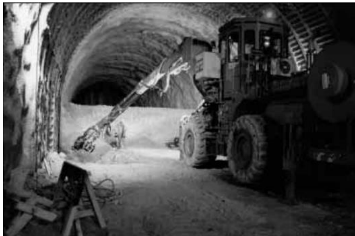
Figure 1.5 Creusement en demi-section. (CETU, 1998)
