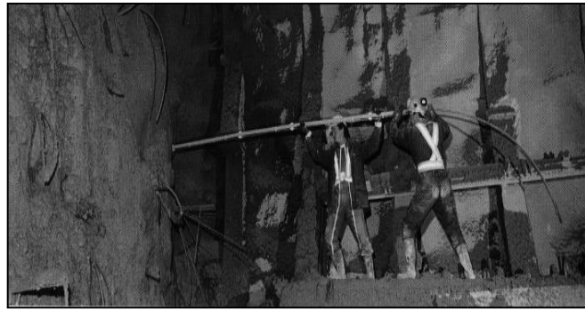
Figure 2.2 Pose de boulons au front de taille (Trompille, 2003)
