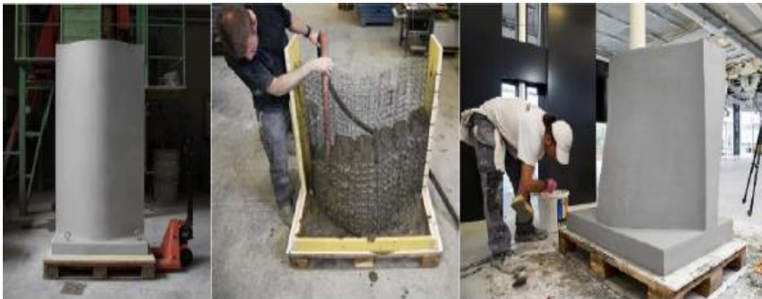
Figure 1.17 : Structure obtenue après coulage du béton et étape de finition talochage [16]
