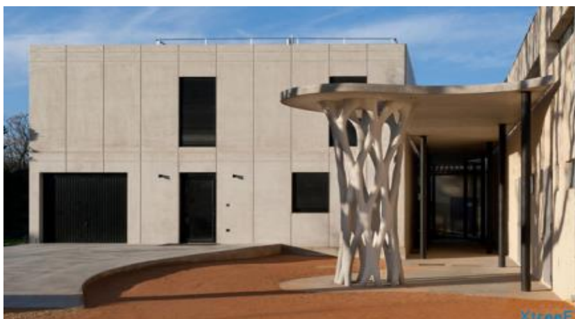
Figure 3.16 : Poteau support à structures poreuses réalisé par fabrication digitale par l'entreprise XtreeE[23].
