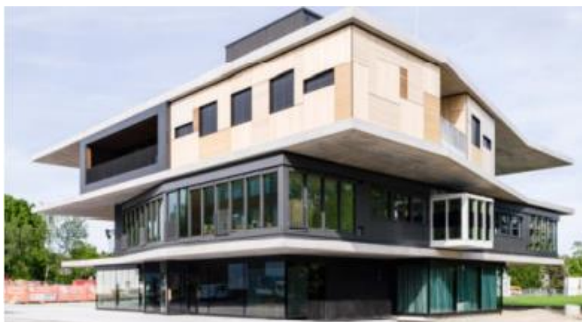
Figure 3.13 : La Dfab House : un bâtiment démonstrateur d'application concrète de la fabrication additive et numérique dans le monde de la construction [19].
