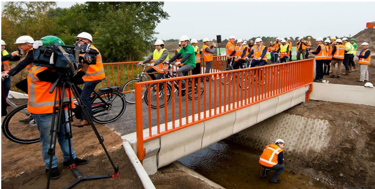
Figure 2.1 : Un premier pont en béton imprimé en 3D aux Pays-Bas
