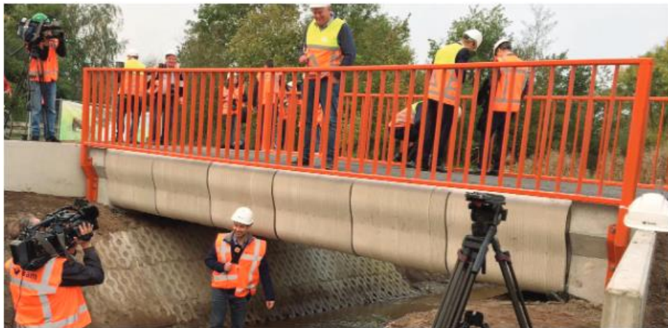
Figure 3.8 : Premier pont en béton imprimé MDM au monde pour vélos à Gemert, Noord Brabant, le jour de l'ouverture. Les couches imprimées contiennent du câble d'acier comme renfort latéral (le pont est précontraint dans le sens longitudinal).[11]
