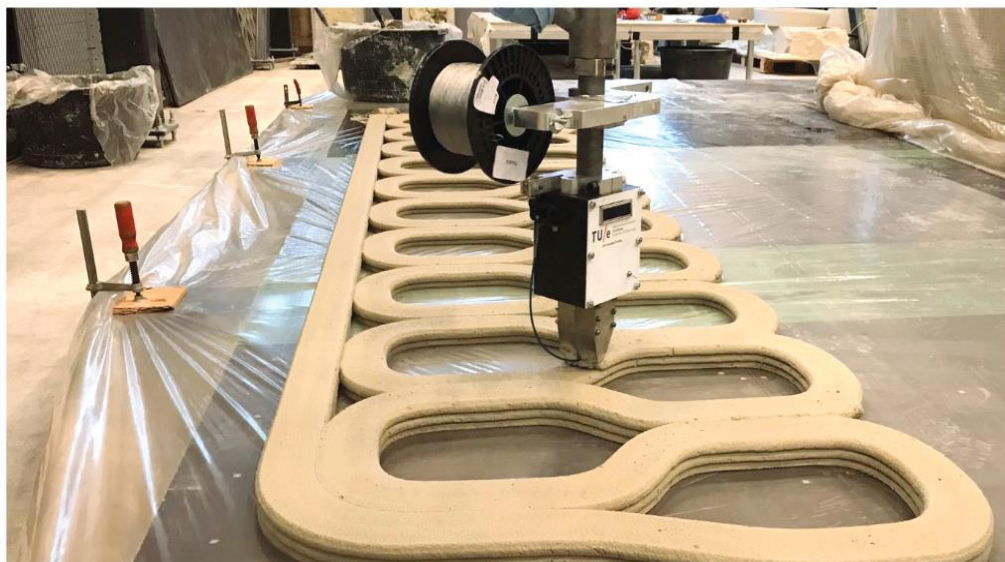
Figure 3.6 : Impression 3D du béton avec une cabine de renfort directement entraînée [11].
