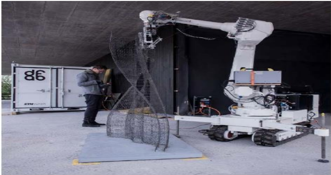
Figure 1.16 : Réalisation du grillage coffrage par le robot soudeur [16]
