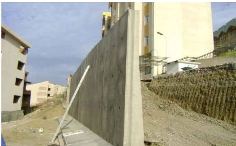
Figure (2.9): mur de soutènement Tlemcen
