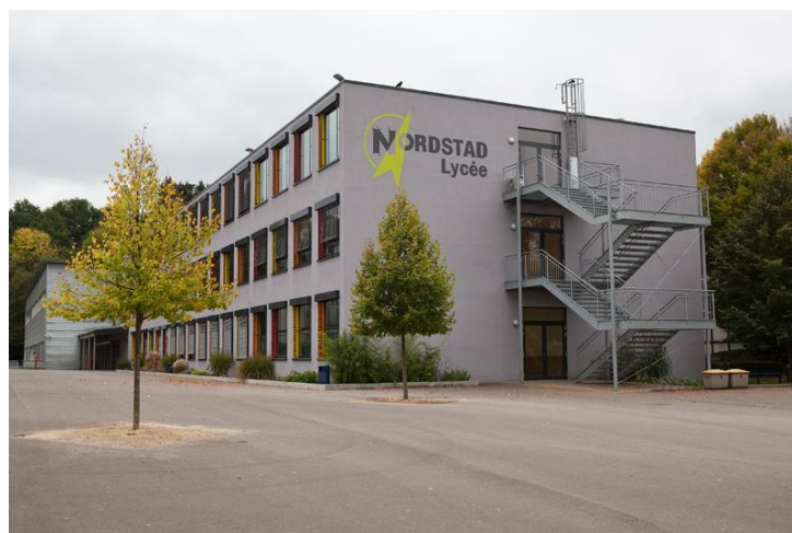
Figure 1.0 : Lycée de Diekirch au Luxembourg (BASF [25]).
