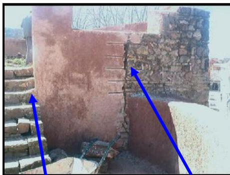
**1 :** *Etat de la muraille ouest : Fissurations des murs et délabrement des escaliers.*
