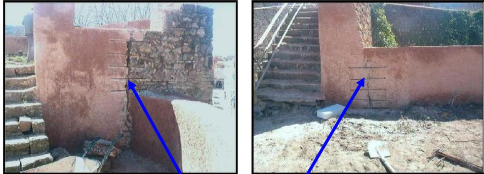
**ILL. 94 :** *Travaux de traitement des fissures de la muraille Ouest<sup>1</sup>*
