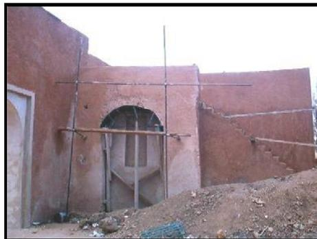
**3:** Confortement d'un traitement en arcade du mur à côté de la porte du Sud.
