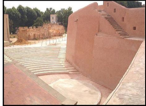
**1** : Travaux de décapage et revêtement en enduit à base de chaux hydraulique.
