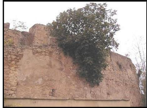
**2 :** *Poussée d'un arbre sauvage à l'intérieur de la parois d'un pan de mur.*
