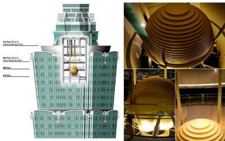
Figure 2.2: TMD pendulaire de la tour de Taipei101 [32]
