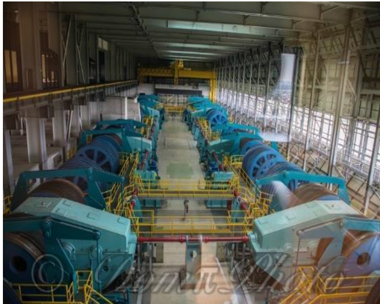
Figure 1.16 salle des machine d'ascenseur Funiculaire de Strépy-Thieu( Belgique)
