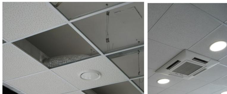
Figure 6.21: Passage des équipements au-dessus du plafond
