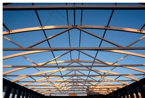
Figure 6.13: exemple d'une poutre en treillis
