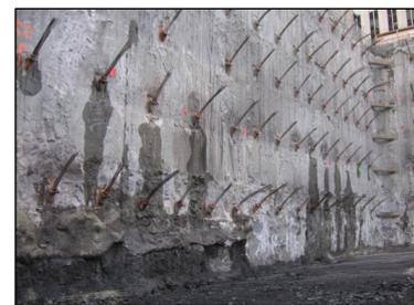
Figure 1.3: Fininstallation de la paroi moulée
