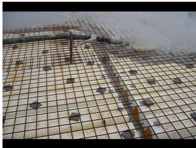
Figure 6.15: Coulage sur place d'une dalle pleine.
