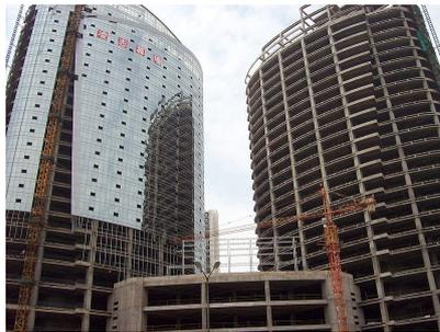
Figure 1.77: Un chantier à Wuhan en Chine. La différence d'avancement des travaux entre les deux tours montre la relation entre la structure porteuse (à droite) et le mur rideau (à gauche).
