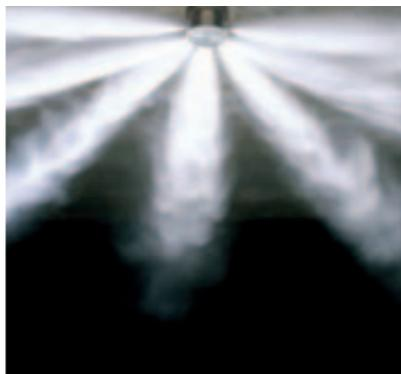
Figure 6.55: Extinction par gaz inertes
