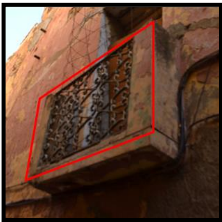
Figure 26: Traitement de façade
