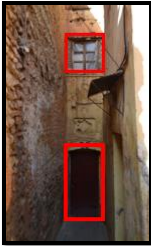
Figure 24: traitement de façade
