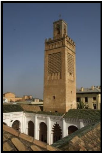
Figure 64: La toiture de la grande mosquée de Tlemcen
