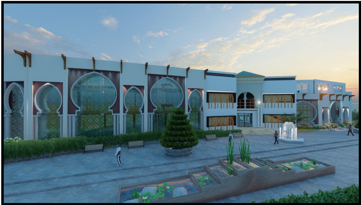
Vue à partir du Boulevard Gaouar Hocine
