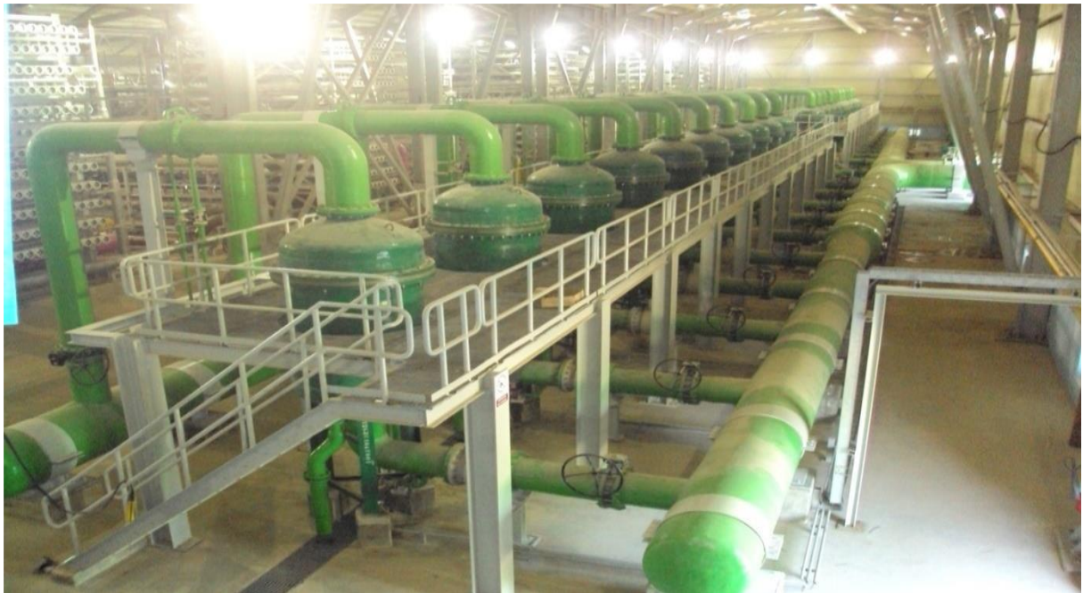
Figure 28: Filtres à cartouches
