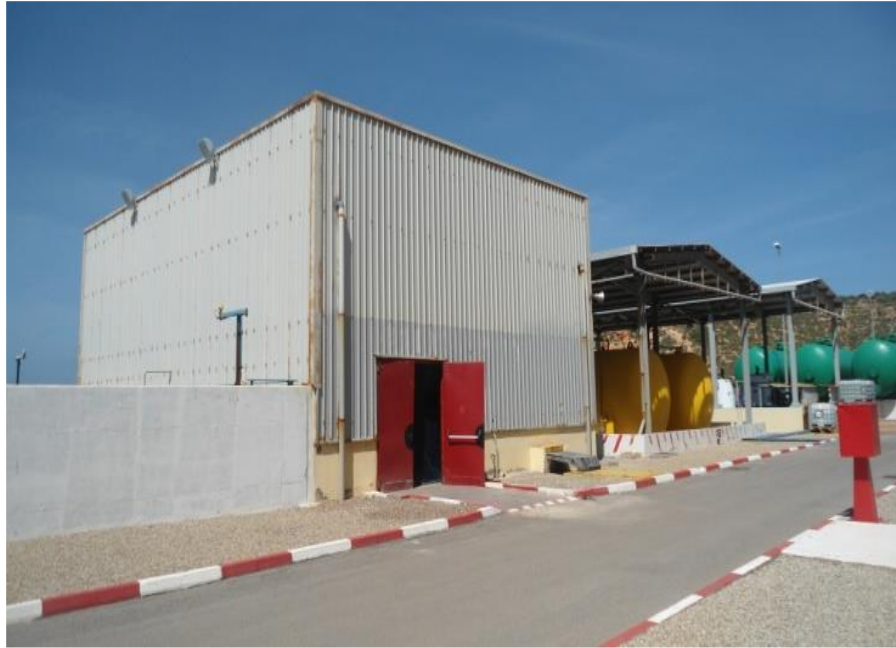
Figure 36: bâtiment de lavage des filtres
