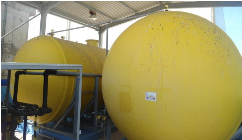
Figure 24: Citernes d'Hypochlorite de sodium
