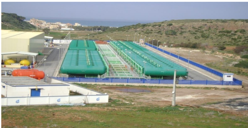
Figure 27: zone des filtres à sable et à anthracite
