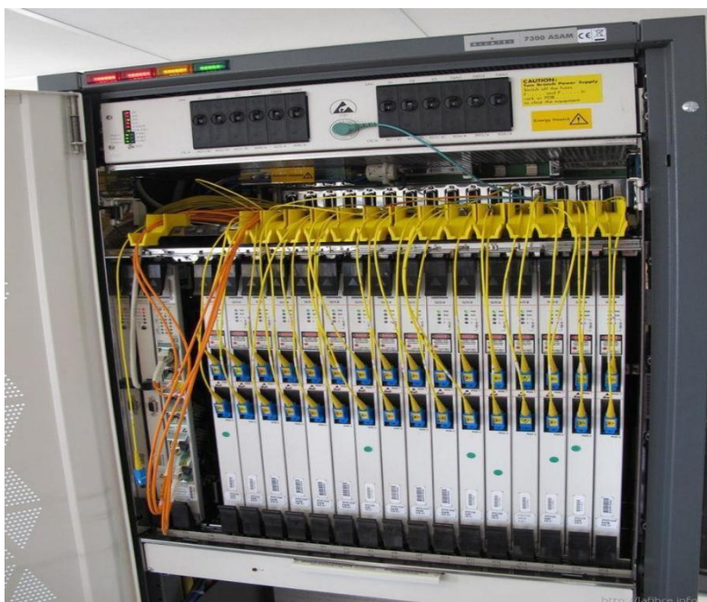
Figure II.10 : exemple d'OLT industriel
