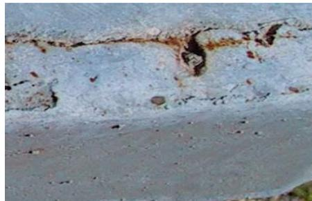
**Corrosion par piqûres** : Cette forme de corrosion est particulièrement insidieuse. L'attaque se limite à des piqûres
