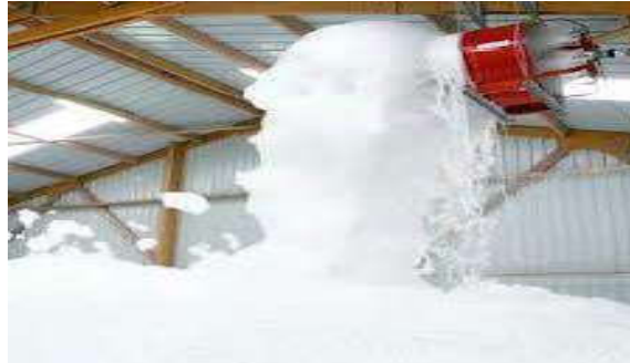
Figure I.0.20 :Mousse a haut foisonnement
