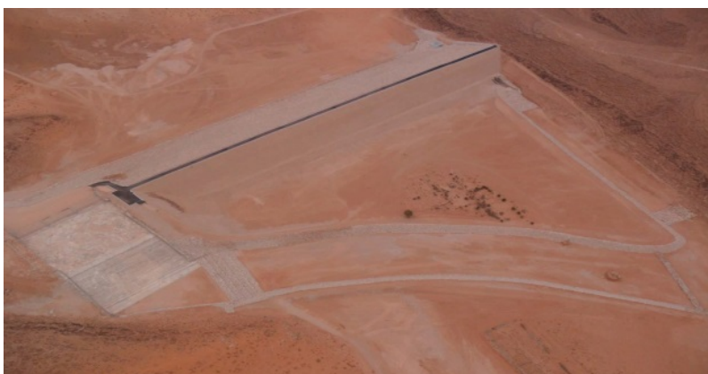
Photo 26 :Digue d'El Himeur pour protéger la vallée du M'zab[51]
