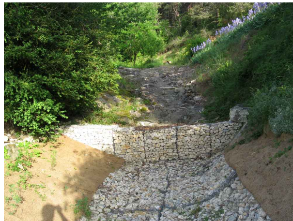
Photo 25: Banquettes de correction torrentielle en gabions[50]
