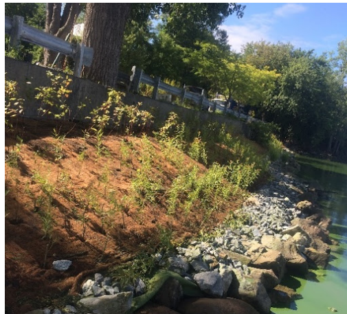
Photo 16 : Stabilisation des berges de rivières par plantation végétale[43]
