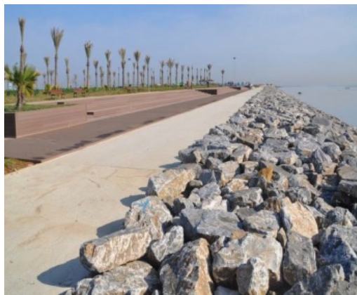
Photo 17 : Stabilisation des berges de cours d'eau par simple enrochements[44]
