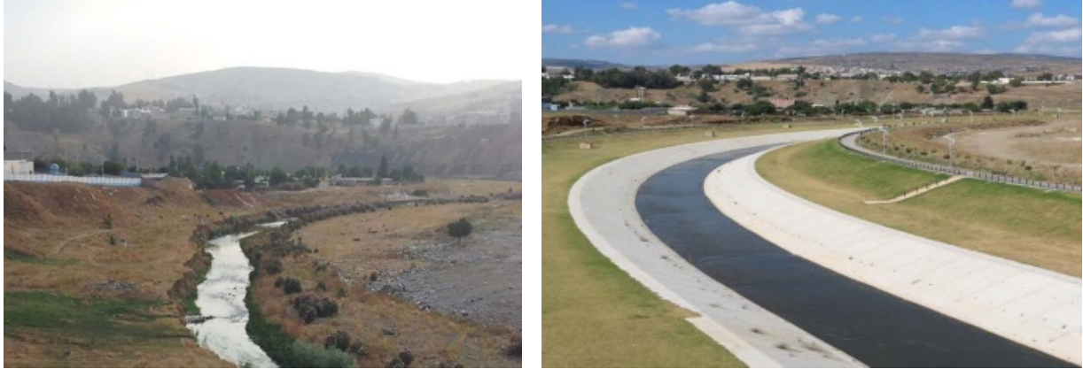
Photo 20 et 21 : Recalibrage et reprofilage de Oued Boumerzoug (Constantine) [46]
