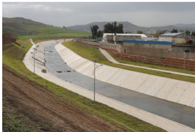
Photo 19 : Recalibrage de la section d'un cours d'eau[44]
