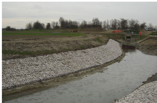
Photo 18 : Stabilisation des berges de cours d'eau par murs en gabionnage[45]
