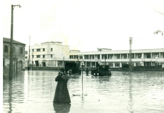
Photo 2 : Inondation à Ghazaoueten 1952[28]
