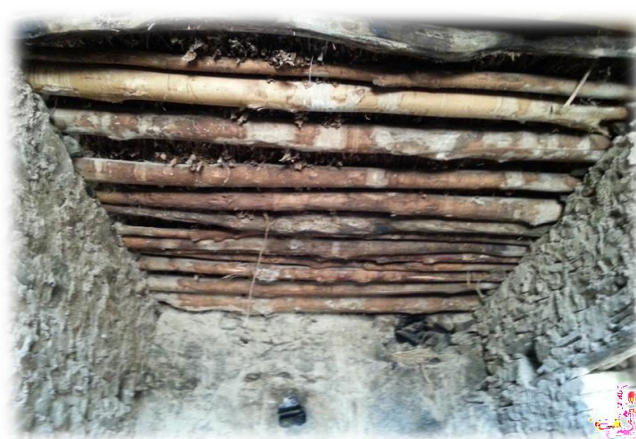
صورة رقم: 15 سقف الغرفة
